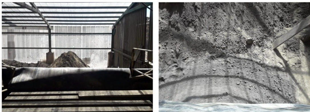
Plateforme imperméable de stockage du concentré
