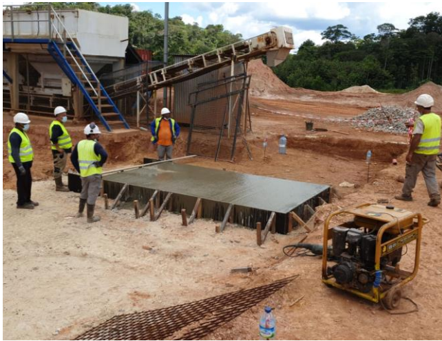
Préparatifs pour l'installation du broyeur à boulets sur le site de Dieu Merci
